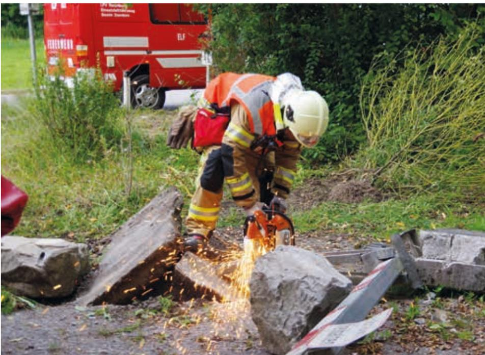
Ein Teil der demolierten Schrankenanlage musste mit der Motor-Flex noch auseinandergeschnitten werden.
